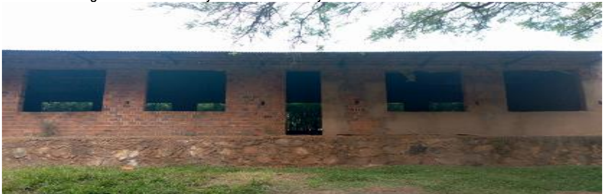
Picha 31: Ujenzi wa vyumba vya madarasa Shule ya Sekondari Nyaruzumbura
