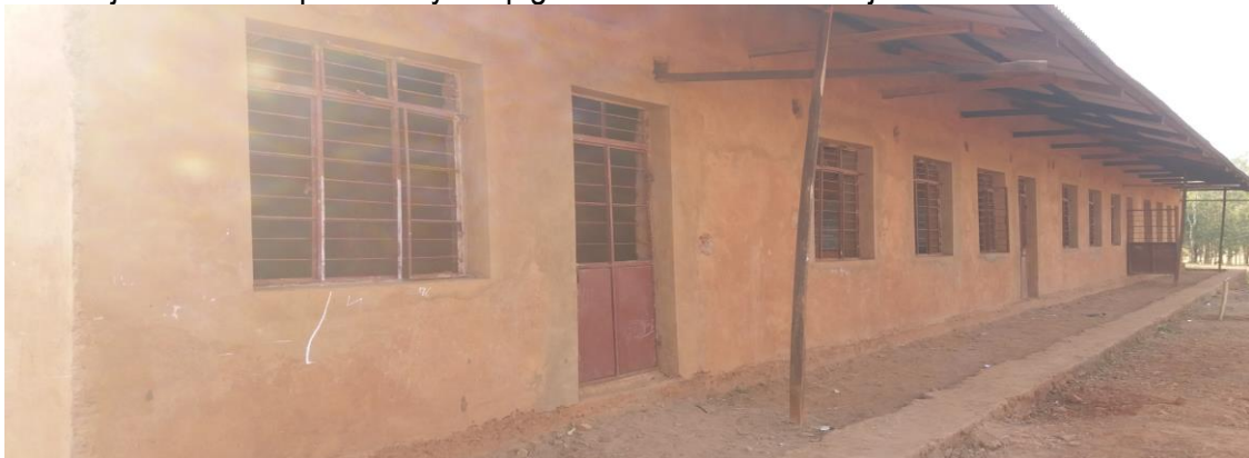
Picha 48: Ujenzi wa vyumba 3 vya madarasa na Ofisi ya Walimu shule ya msingi Kasharara
