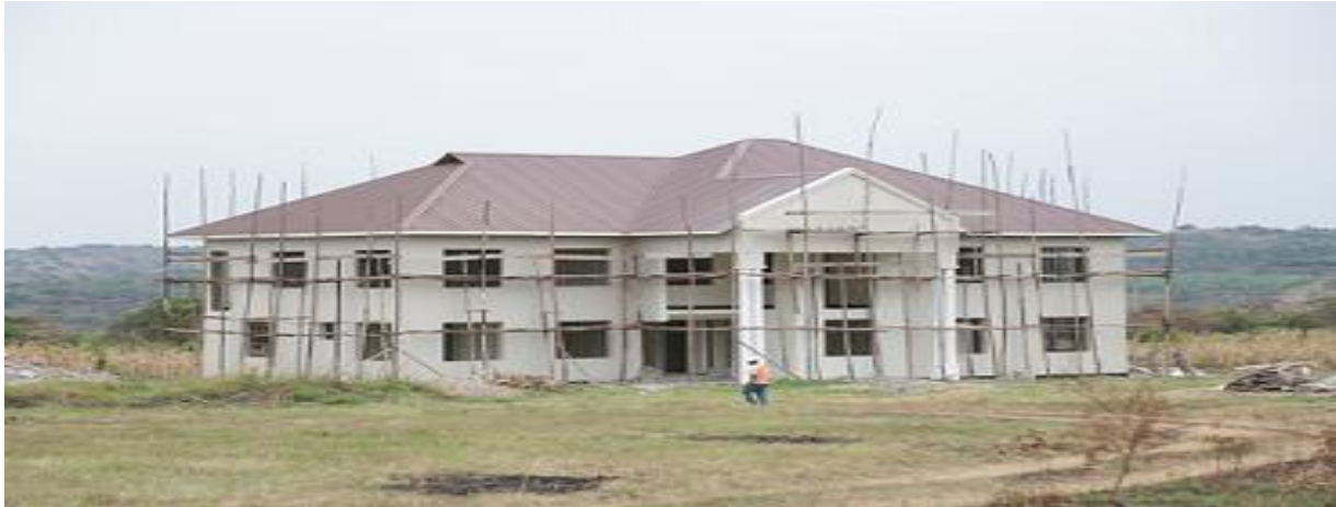
Picha 17: Jengo la Ofisi ya mkuu wa Wilaya linaloendelea kujengwa eneo la Makao Makuu Rubwera
