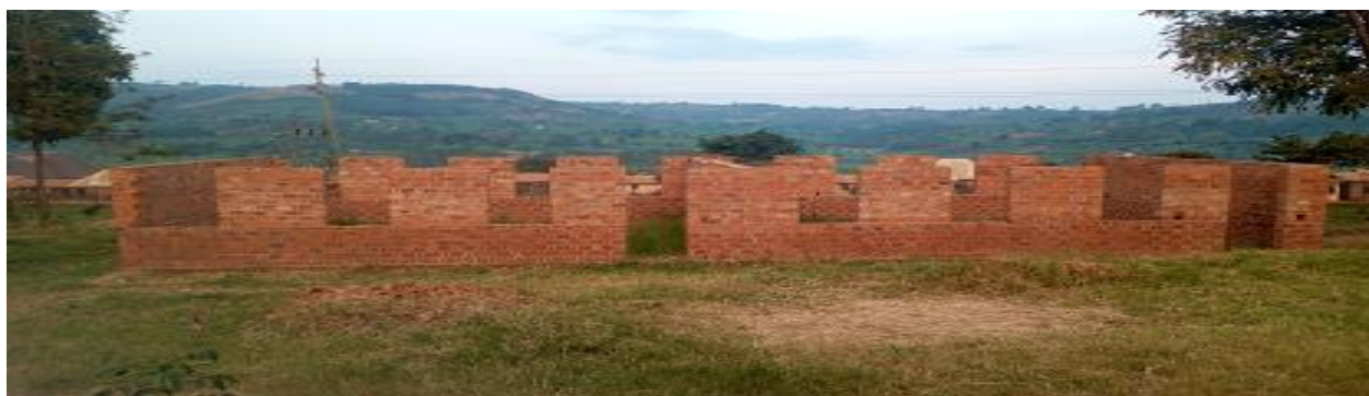
Picha 36: Ujenzi wa vyumba vya madarasa Shule ya Msingi Kimuli
