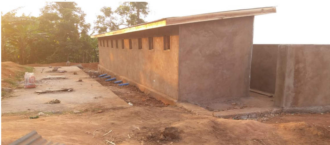
Picha 46: Ujenzi wa matundu 16 ya vyoo shule ya msingi Songambe
