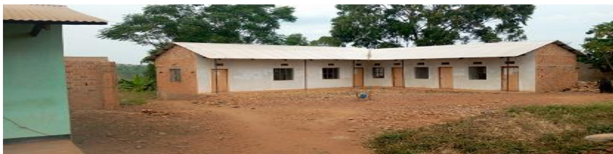
Picha 53: Ujenzi wa jengo la Ofisi ya Kata ya Businde
