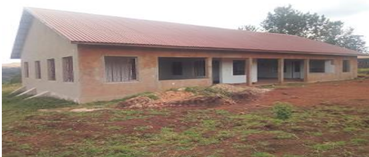
Picha 43: Ujenzi wa jengo la Zahanati ya Iteera
