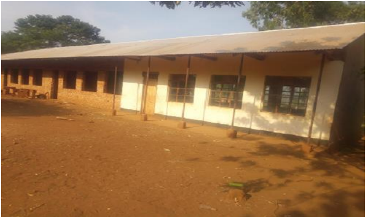
Picha 14:Ujenzi wa vyumba 3 vya madarasa S/M Kishanda
