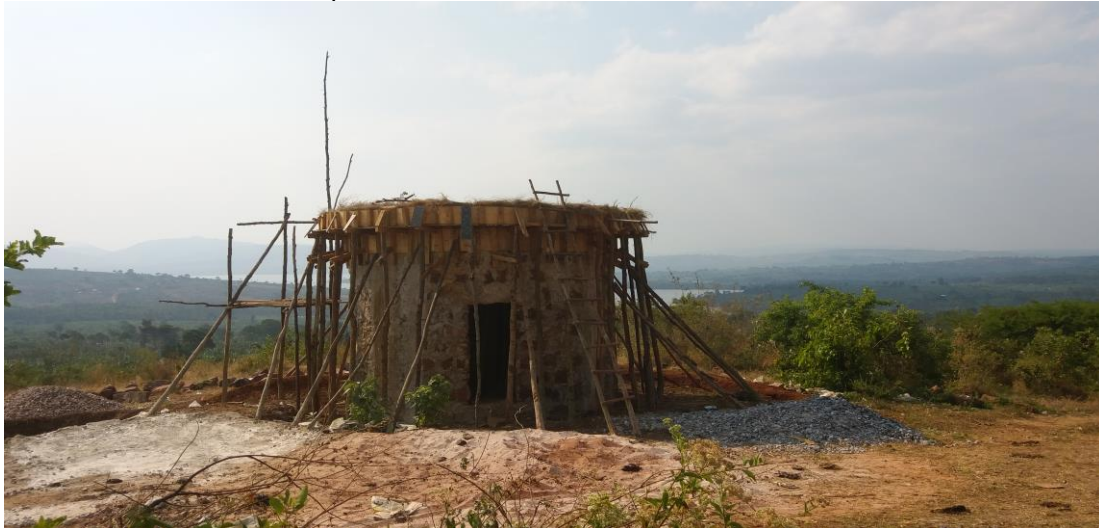
Picha 39: Ujenzi wa tanki la maji Kitwechenkura
