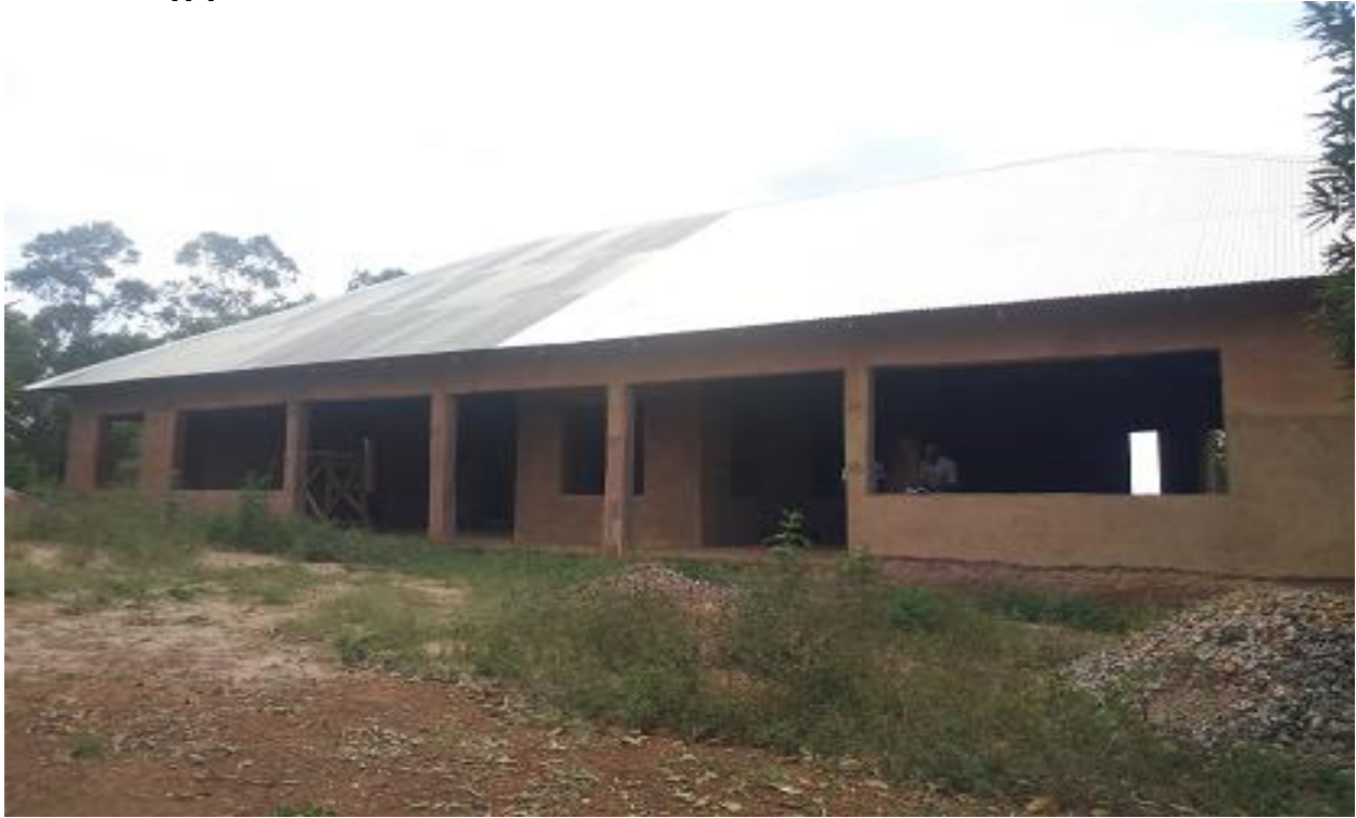
Picha 44: Ujenzi wa jengo la Zahanati ya Chanya
