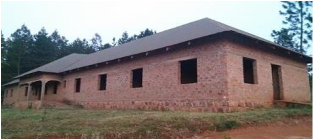
Picha 41: Ujenzi wa Jengo la Wodi ya Wazazi Kituo cha Afya Nkwenda
