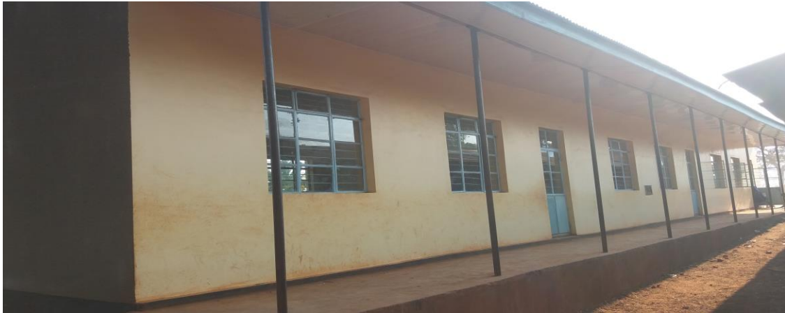
Picha 38: Ujenzi wa vyumba vya madarasa shule ya msingi Kasharara
