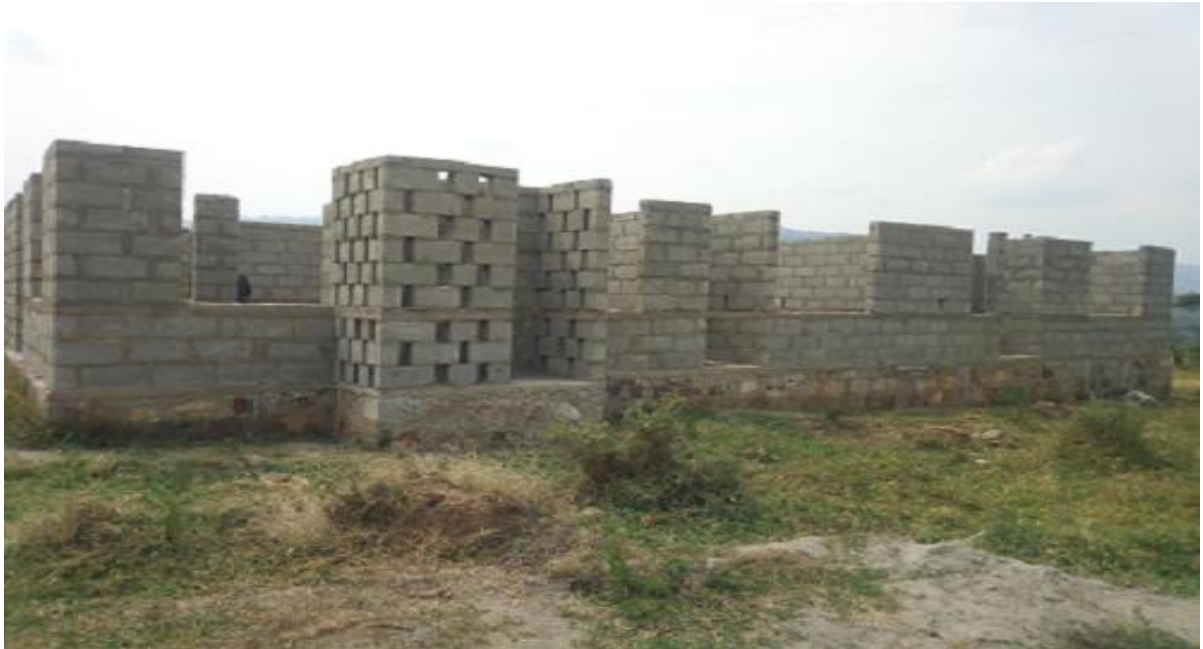
Picha 32: Jengo la zahanati ya Kijiji cha Katera linaloendelea kujengwa
