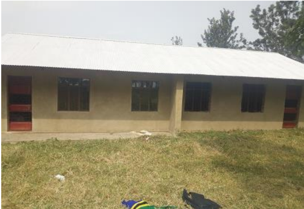
Picha 6: Ujenzi wa nyumba ya Walimu (2 in 1) Shule ya Sekondari Ibanda- Kibingo
